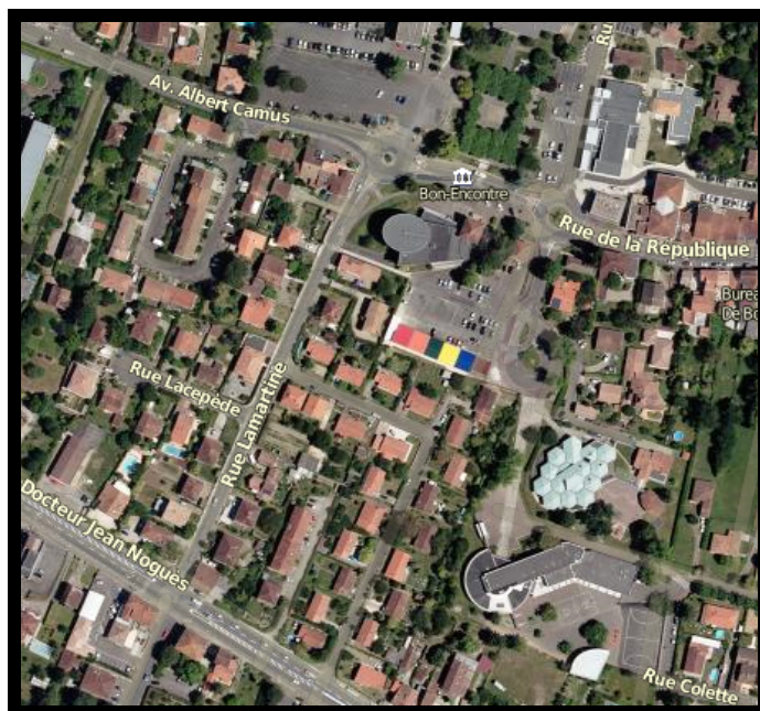
Travaux 2016 : D269 – Rue de la République
